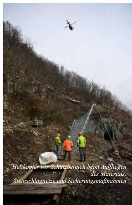
Helikopter vor Schutzbereich beim Aufhängen des Materials. Steinschlagnetze und Sicherungsmaßnahmen
